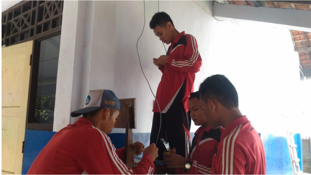
Gambar 2.1 Instalasi Kabel Jaringan Wifi
